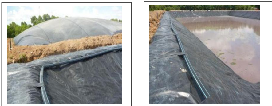
Hình 23 Lắp đặt ống thu khí xung quanh hồ khí sinh học
