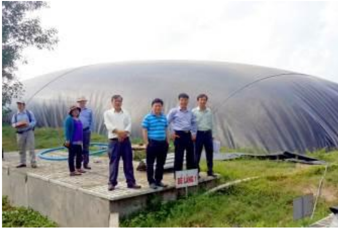
Hình 2: Hồ KSH phủ bạt HDPE xử lý chất thải chăn nuôi có thể tích 500 m 3 tại huyện Phù Cát, tỉnh Bình Định
