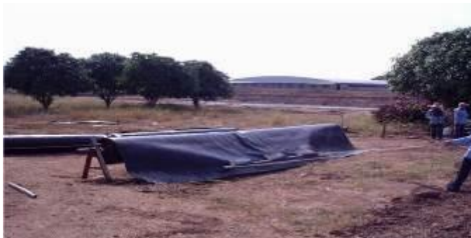
Hình 18 Chuẩn bị địa điểm để hàn bạt HDPE thành tấm lớn lót đáy hồ
