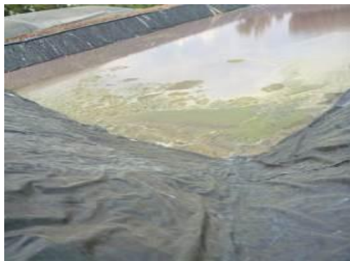
Hình 21 Bơm nước vào hồ để thử kín nước của bạt HDPE lót đáy hồ
