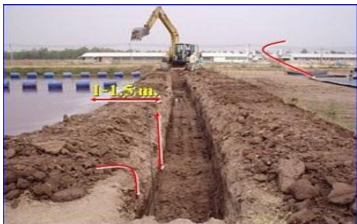
Hình 17 Rãnh neo bệ HDPE xung quanh hồ khí sinh học
