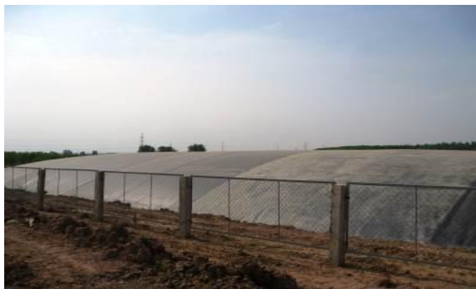
Hình 29 Hồ KSH sau khi được kiểm tra kín khí
