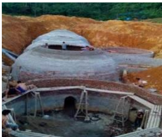
Hình 6 Hệ thống các bể 200m 3 nối với nhau
