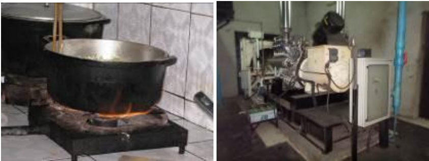
Hình 29 Bếp và máy phát điện KSH
