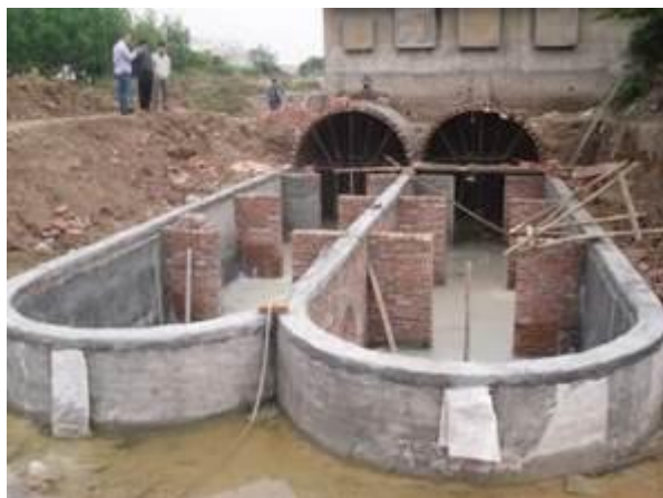
Hình 5 Bể KSH hình ống, mỗi bể 100 m 3
