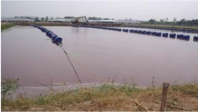
Hình 25 Hệ thống phao dùng để kéo tấm bạt HDPE phủ hồ KSH
