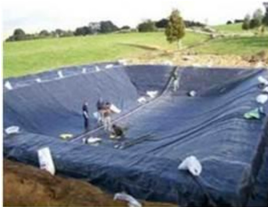
Hình 20 Trải bạt HDPE lót đáy hồ
