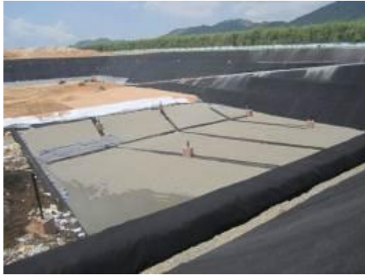
Hình 1: Xử lý chất thải bằng hồ chôn lấp được lót và phủ bạt HDPE
