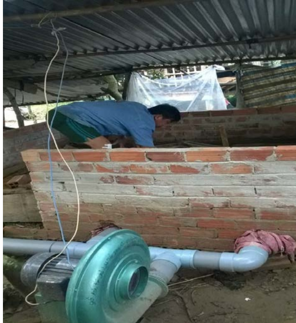
Hình : Quạt gió thổi khí của hệ thống ASP
