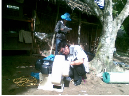
1. Lắp đặt quạt ly tâm
