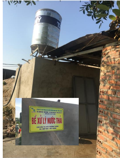
Bể xử lý nước thải công nghệ của Công ty Tiên Long được lắp đặt ở HTX Trường Thành, Bắc Giang, lọc nước thải sau KSH, nước sau lọc được đưa vào hồ cá
