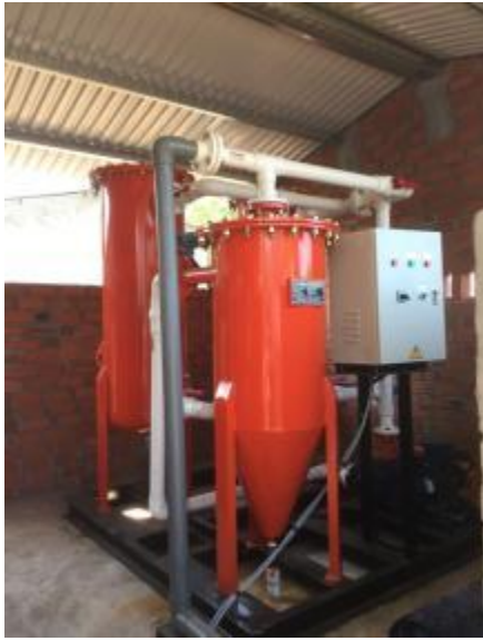
Bộ lọc cho máy phát LSA42.3L9 55.2kW / 3 phase thuộc gói 36 tại trang trại Huy Tuyệt Bình Định
