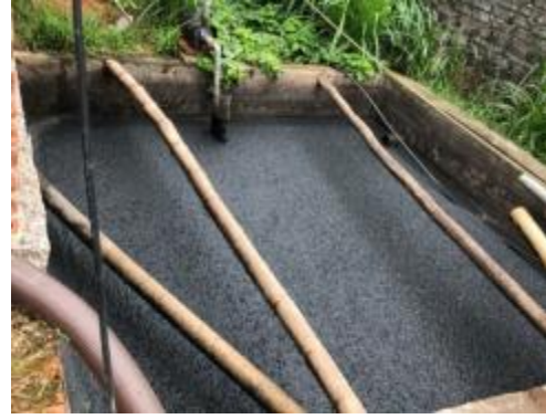
Đầu ra công trình KSH tại Phú Thọ
