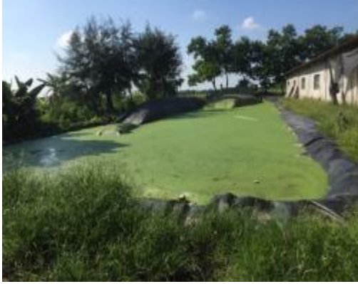
Công trình KSH bị hỏng tại Nam Định
