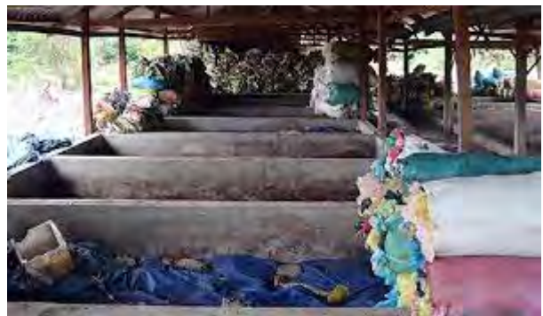
Hình 2.1.5. Xây từng hố kín
