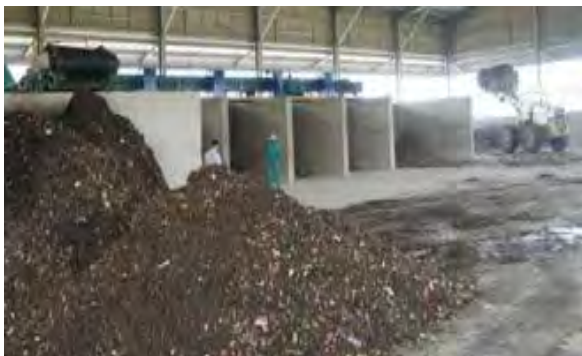
Hình 2.1.4. Xây hố dài hở 2 đầu
