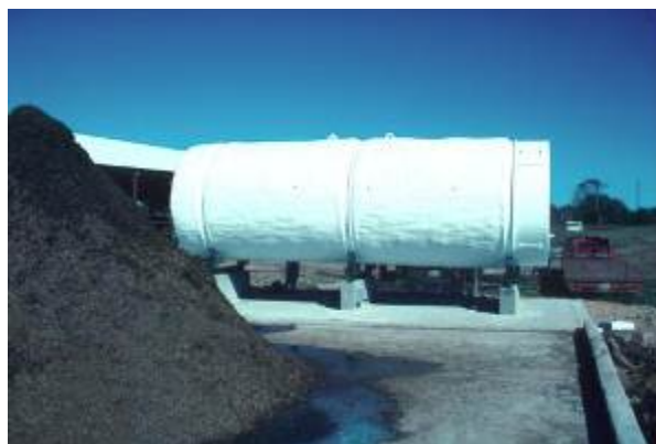
Hình 7. Mô hình xử lý chất thải trong thùng quay (hệ thống sinh hóa)
