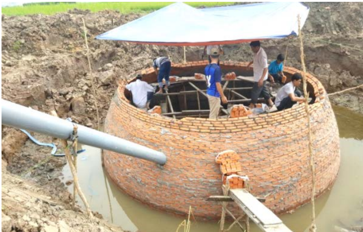
Thực hành xây dựng công trình KSH vừa
