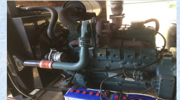
Máy phát điện dùng diesel 225 kVA (máy cũ nhưng mới được mua về sử dụng) ở Bình Định
