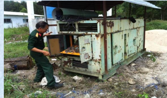
Máy phát điện dùng diesel 60 kVA (hàng nội địa) ở Bình Định, hiện đang bị hỏng không sử dụng
