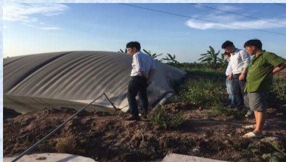
Kỹ thuật viên thực địa khảo sát hầm KHS tại Nam Bắc Giang
