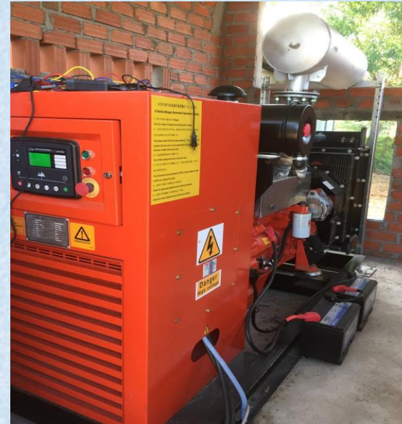
Máy phát điện dùng diesel 60 kVA/ 50 kW (Trung Quốc sản xuất) ở Bình Định
