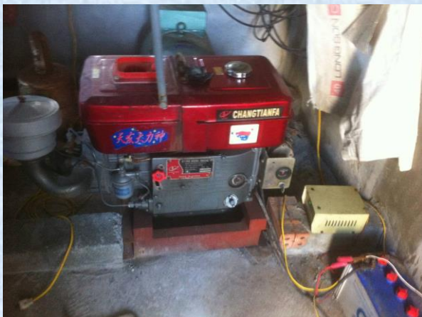
Máy phát điện 25kW chạy diesel tại Nam Định
