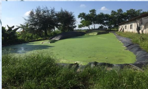
Công trình KSH bị hỏng tại Nam Định
