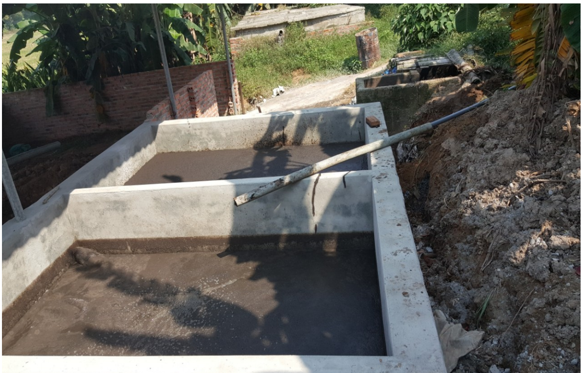
Hình 9. Bể lọc hoạt động tốt: 3 ngày lọc được 1 m 3 /10m 3 /1 ngăn. Bể có 3 ngăn lọc luân phiên. Như vậy cứ 1 ngày lọc 10m 3 chất thải. Chất lượng tách phân tuyệt vời với chi phí rất thấp (cho quy mô 1000 lợn thịt)
