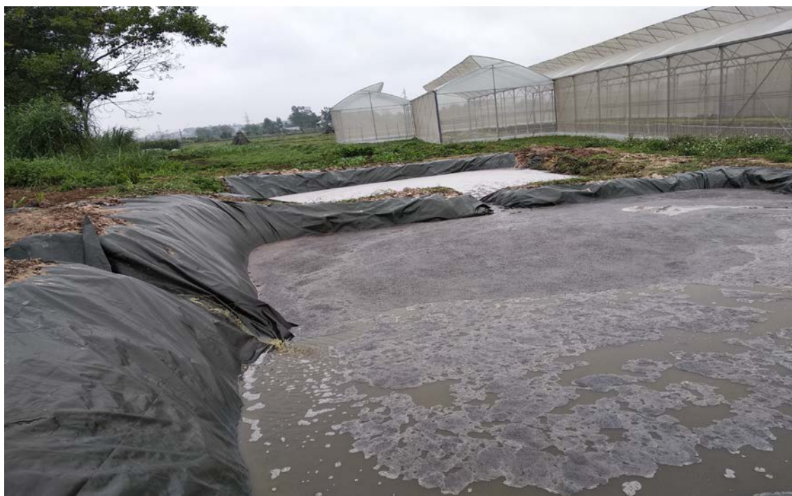
Hình 13. Hệ thống ao thu chất thải lỏng sau khi tách/lọc
