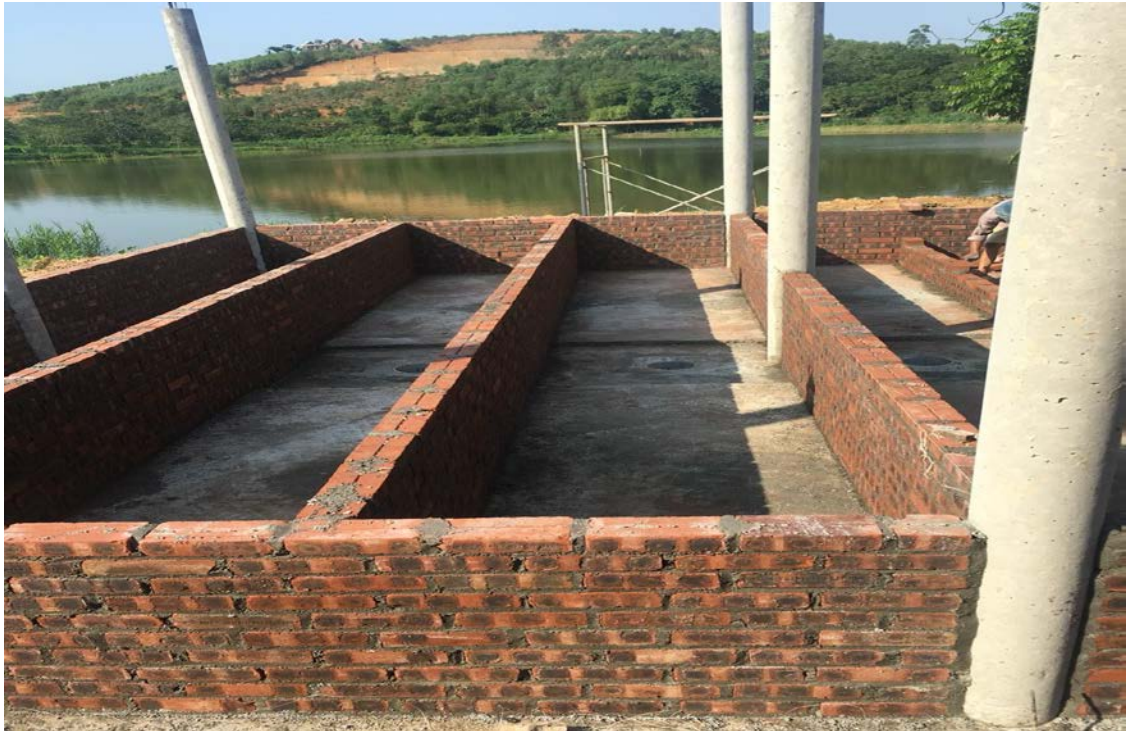
Hình 2: Hàm chứa phân dưới chuồng sà đang được xây dựng (thôn 5, xã Vụ Quang, huyện Đoàn Hùng, tỉnh Phú Thọ)
