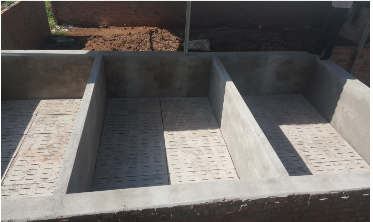
Hình 8. Bể lọc tách/lọc chất thải có 3 ngăn 2 đáy đơn giản, chi phí thấp (thôn Đồng Tâm 3, xã Thường Thắng, huyện Hiệp Hòa, tỉnh Bắc Giang)
