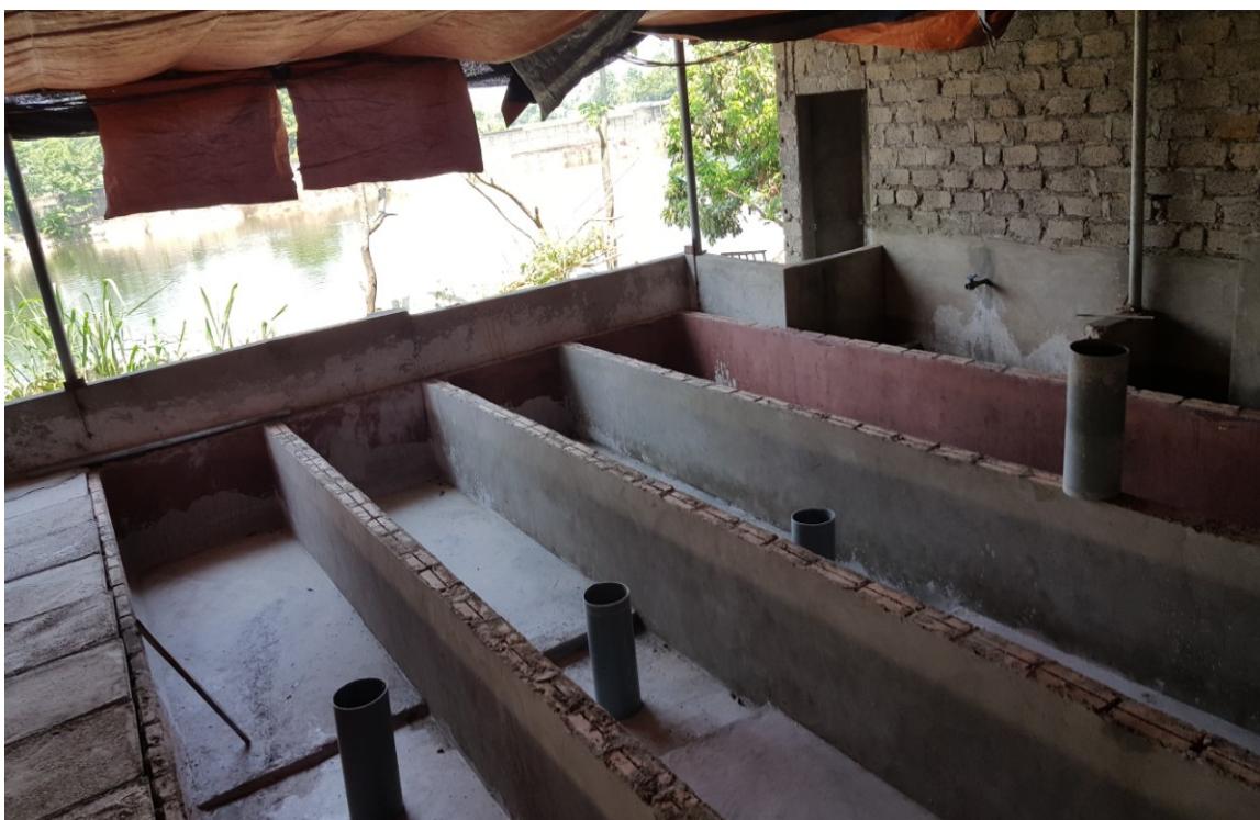
Hình 4. Mô hình chuồng sàn cải tạo đang xây phần hầm chứa phân (thôn Danh Thượng 2, xã Danh Thắng, huyện Hiệp Hòa, tỉnh Bắc Giang)
