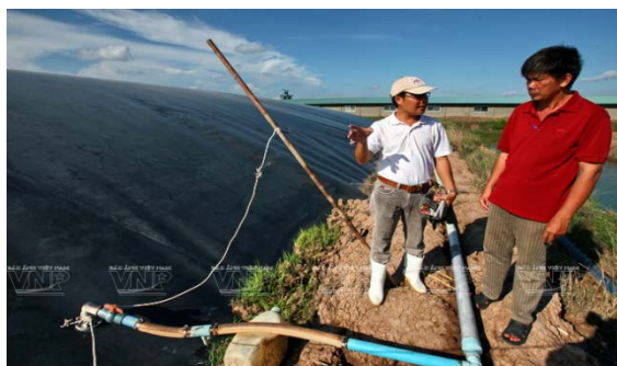
Hình 3.5 – Thường xuyên kiểm tra độ kín của đường ống và van khí
