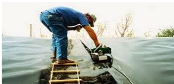
Hình 3.3 - Vá bạt bằng phương pháp hàn đùn trong điều kiện hồ còn đầy khí
