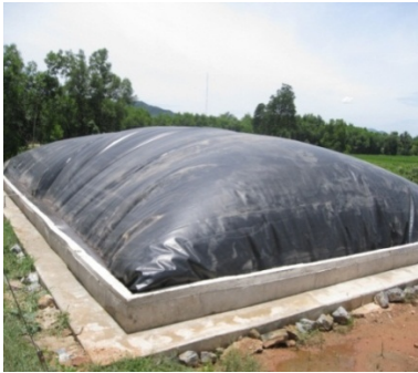
Hình 3.1 - Rãnh thoát nước quanh hồ HDPE
