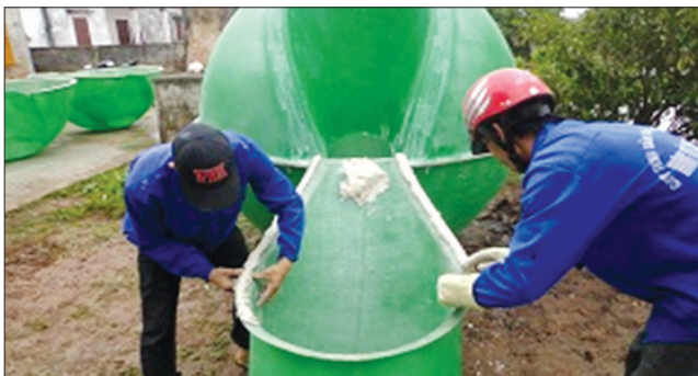
Hình 22. Trát keo để lắp tai công trình composite
