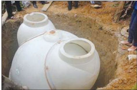
Hình 26. Hạ công trình xuống hố đào
