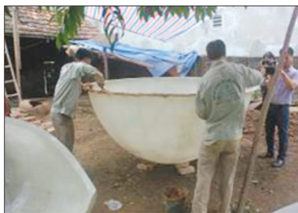
Hình 23. Trét keo bột nắp dưới
