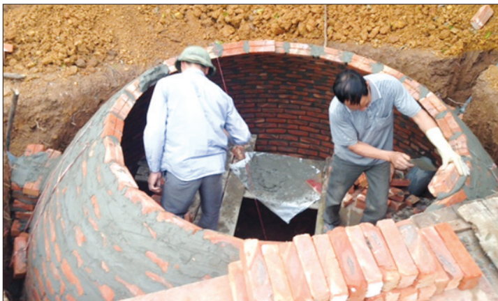
Hình 8. Xây dựng công trình khí sinh học
