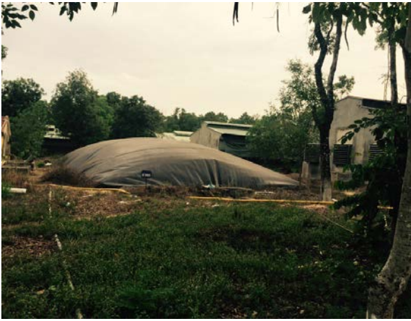
Bể KSH tại Trại heo giống Bình Minh
