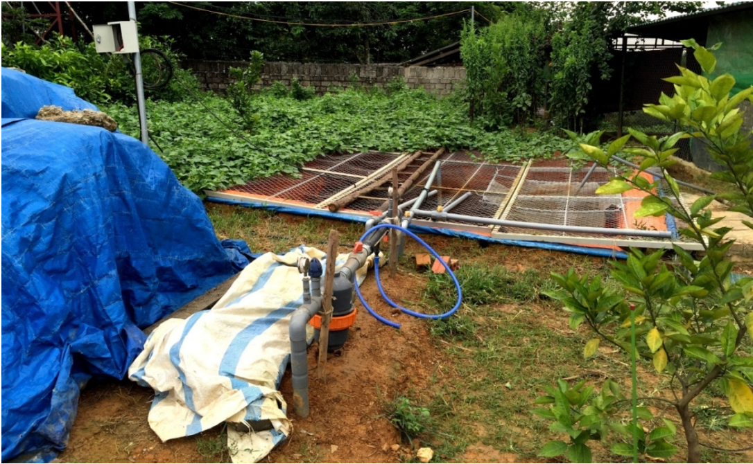
Bể chứa nước xả bể KSH phục vụ máy tưới cho vườn cây ăn quả trang trại ông Cầu, khu 12, xã Tiên Kiên, huyện Lâm Thao, tỉnh Phú Thọ
