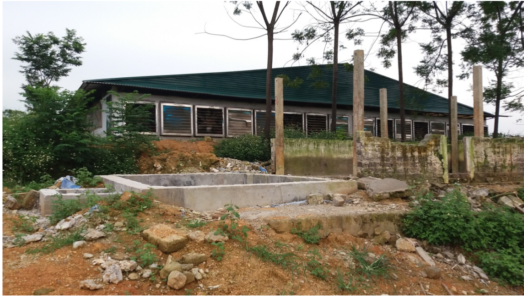
Bể chứa nước thải phục vụ máy tách chất thải rắn hộ bà Thìn, xã Phú Hộ, TX Phú Thọ
