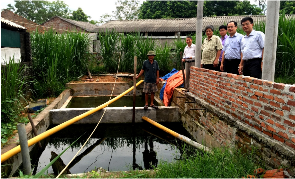
Bể chứa nước thải phục vụ máy tách chất thải rắn hộ ông Thân, xã Thạch Hà, TX Phú Thọ
