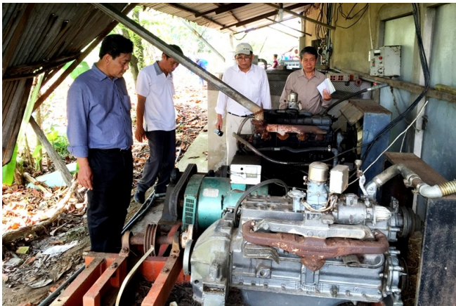
Hộ ông Trần Huỳnh Trung, xã Long Bình Điền, huyện Chợ gạo đã từng sử dụng 2 máy phát điện sử dụng khí gas, song do không có hệ thống lọc khí nên đã bị hỏng nhiều năm
