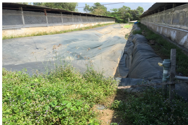
Bể KSH hộ ông Trần Huỳnh Trung, xã Long Bình Điền, huyện Chợ gạo bị hư hại
