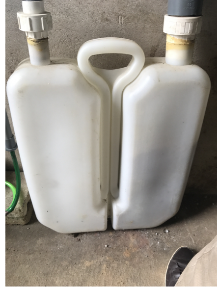
Hình 3: Một số hình ảnh bộ tinh lọc cho máy phát điện KSH
