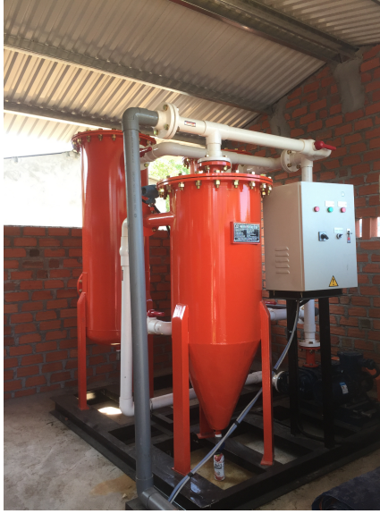
Hình 3: Một số hình ảnh bộ tinh lọc cho máy phát điện KSH
