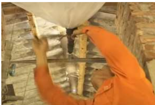
Hình 3.8. Lắp đặt ống dẫn khí biogas vào túi khí
