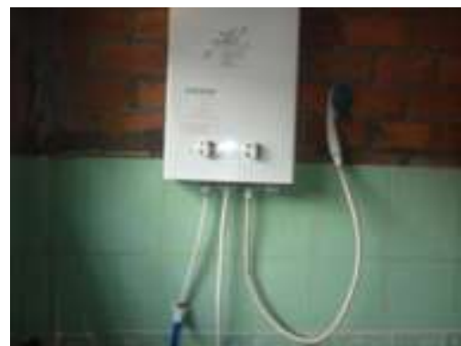
Hình 2.5.49. Thiết bị được lắp đặt xong
