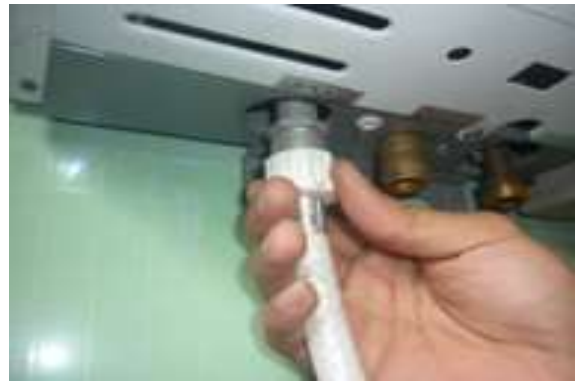
Hình 2.5.43. Nối ống dẫn KSH vào thiết bị
