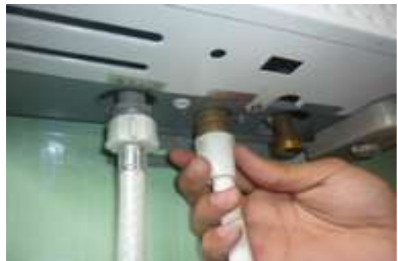
Hình 2.5.46. Lắp đầu nối cấp nước
