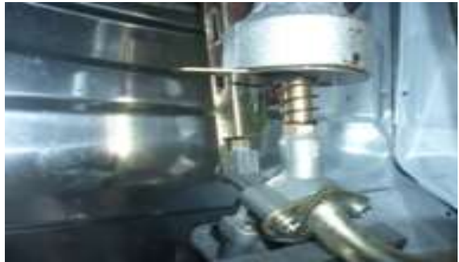
Hình 2.2.6. Lắp đầu đốt
