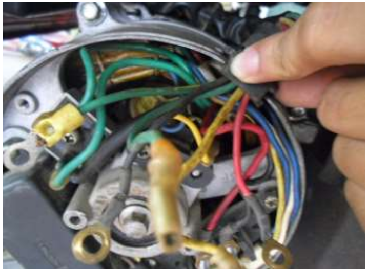
Hình 5.35. Lắp dây từ bảng điều khiển vào hộp cực
