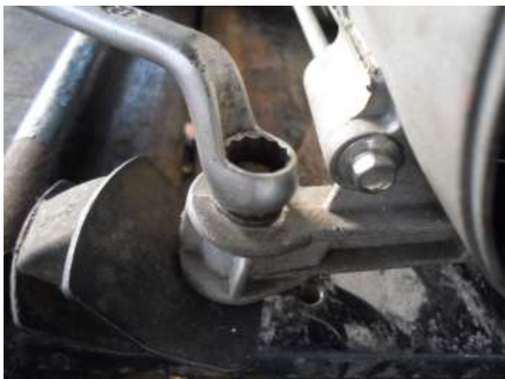
Hình 4.18. Kiểm tra bu lông liên kết tổ máy phát điện với đế đặt máy
