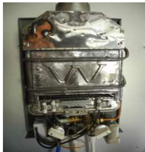
Hình 2.5.31. các bộ phận cấu tạo bên trong được lắp đặt
