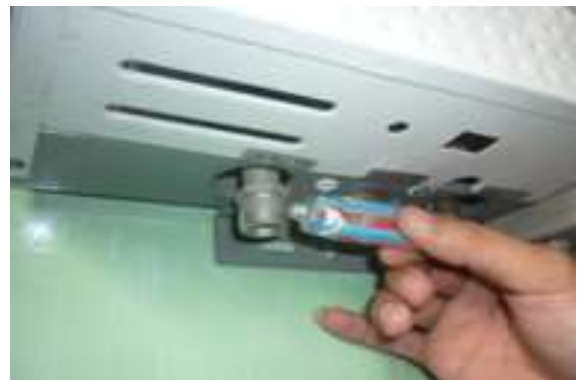
Hình 2.5.42. Chuẩn bị lắp ống dẫn KSH
