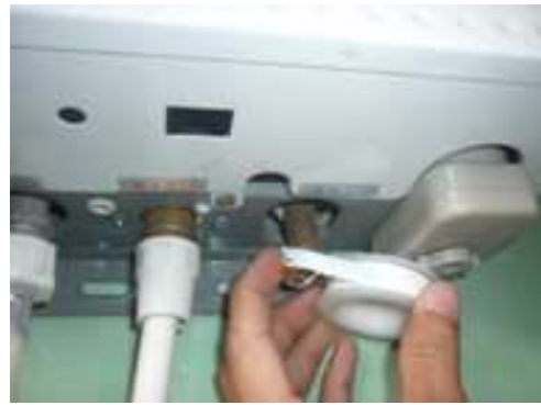
Hình 2.5.47. Chuẩn bị lắp nối ống dẫn nước (nóng) ra từ thiết bị
