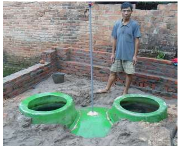
Hình 1.2.31. Hầm ủ KSH làm bằng vật liệu composit
