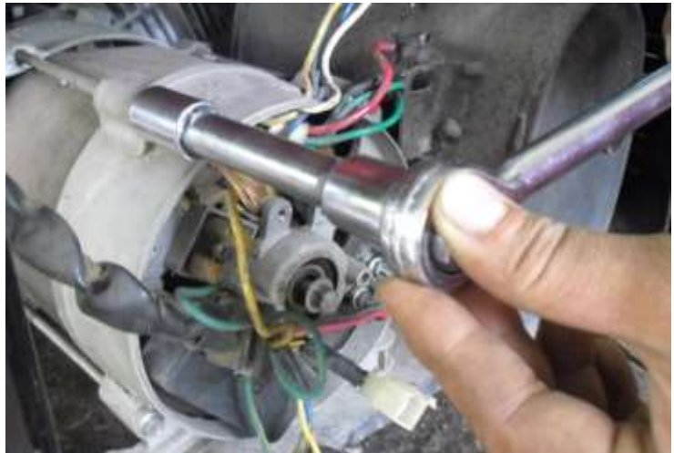
Hình 5.26. Xiết chặt ốc cố định stato với nắp
