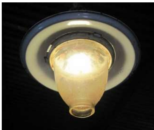
Hình 1.2.19. Bóng đèn được thắp sáng bằng KSH
