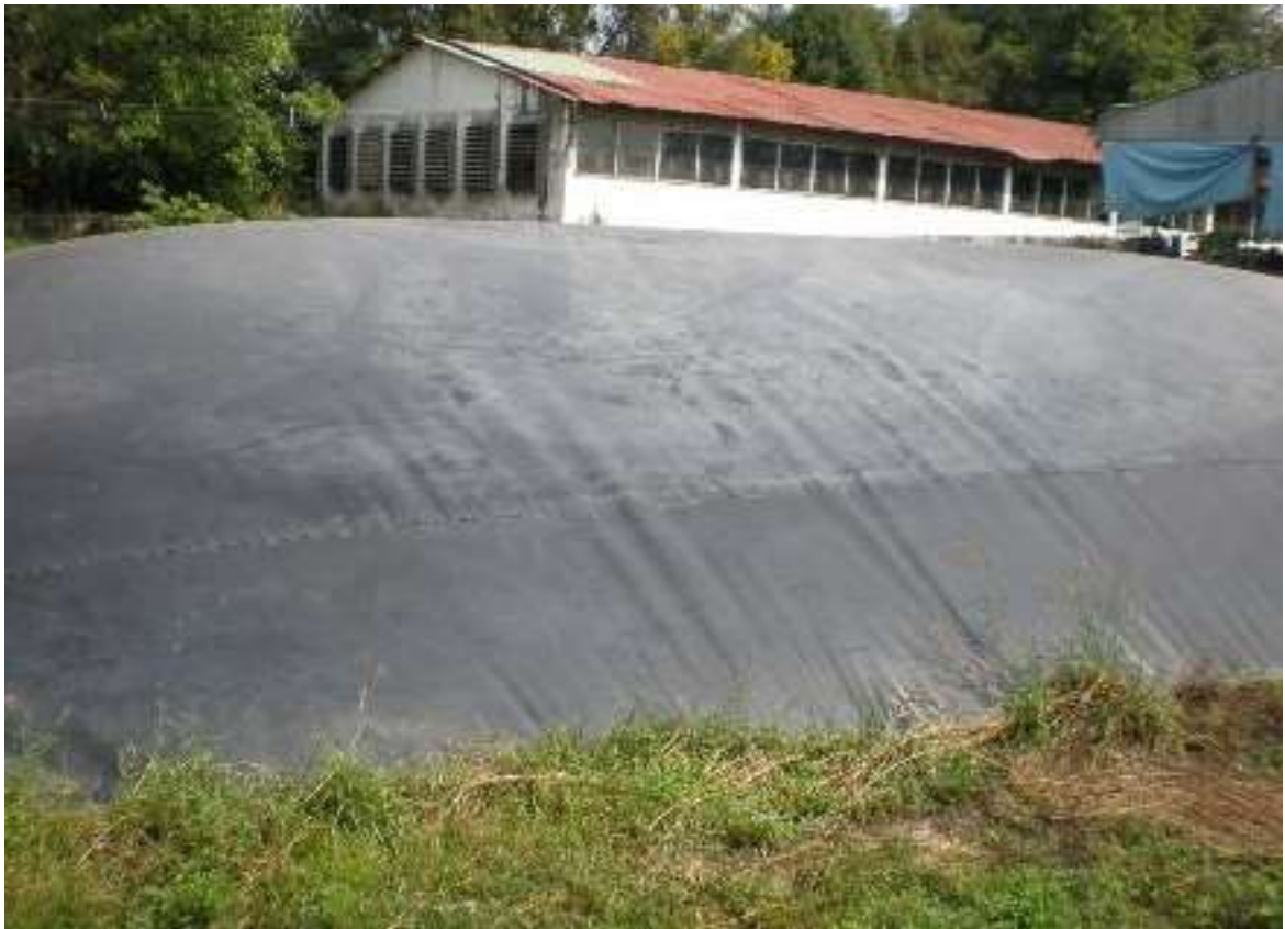
Hình 1.2.32. Hầm ủ KSH làm bằng vật liệu HDPE
