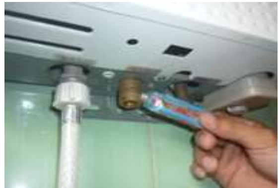
Hình 2.5.44. Bôi keo dán vào đầu nối ống cấp nước
