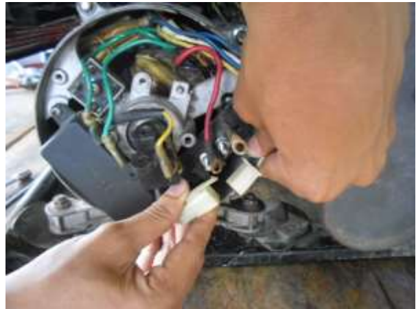
Hình 5.12. Tháo dây nguồn ngõ vào bộ tự động điều chỉnh dòng kích từ
