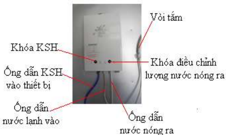
Hình 2.5.1. Thiết bị đun nước nóng dùng KSH
