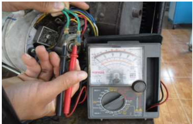
Hình 5.72. Kiểm tra điện áp ngõ vào cầu chỉnh lưu
