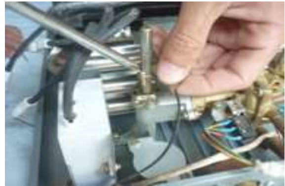
Hình 2.5.21. Nối dây tiếp mát
