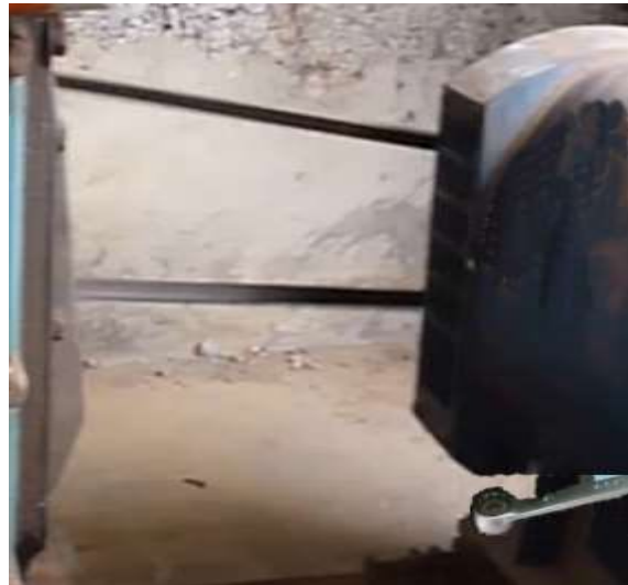
Hình 3.30. Siết lại bu lông liên kết máy phát điện với khung máy
