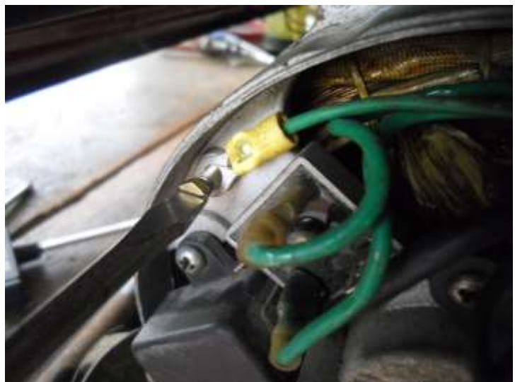
Hình 5.36. Lắp dây tiếp đất
