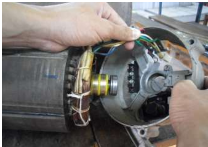
Hình 5.22. Đưa đầu dây quấn stator ra hộp cực máy phát điện
