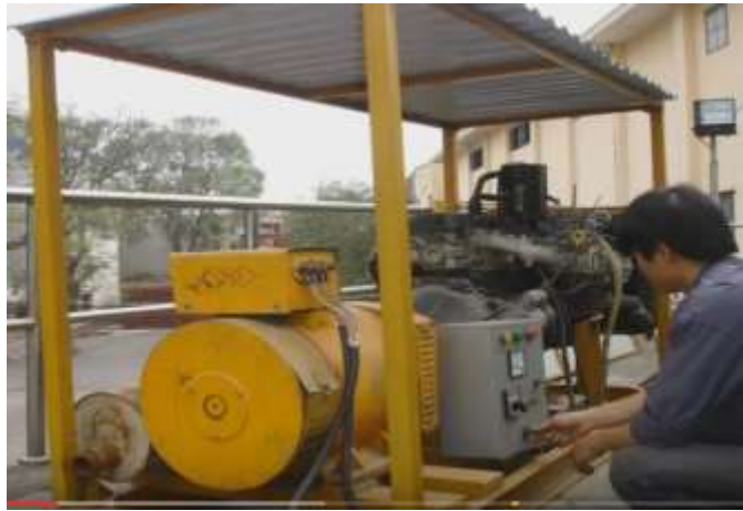
Hình 3.4. Lắp đặt máy phát điện ngoài trời
