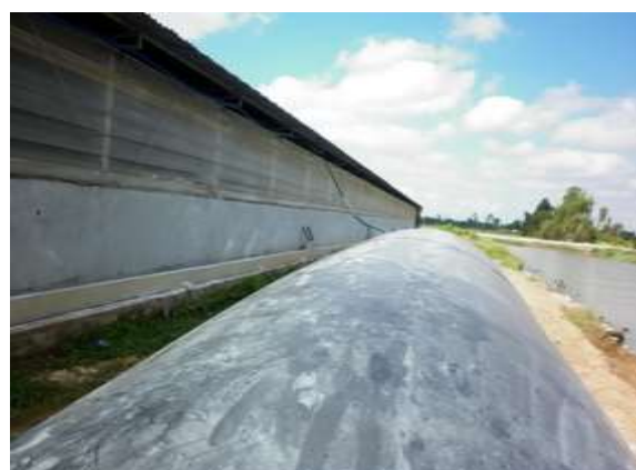
Hình 1.2.34. Hàm ủ KSH được làm phù hợp với điều kiện sản xuất
