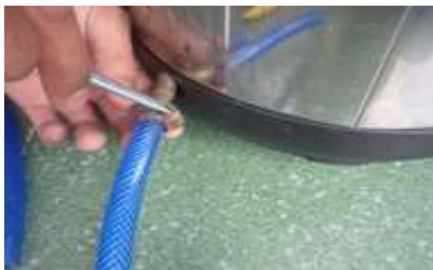
Hình 2.4.12. Lắp ống dẫn khí vào nồi
