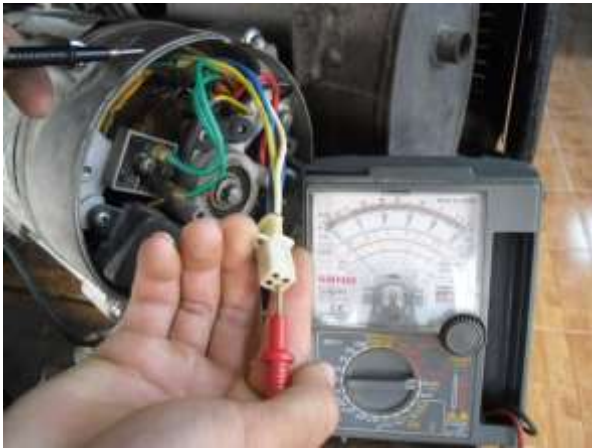
Hình 5.44.b. Đo cách điện cuộn dây cấp nguồn cho bộ tự động điều chỉnh dòng kích từ
