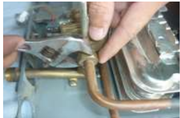
Hình 2.5.18. Kết nối ống dẫn nước nóng
