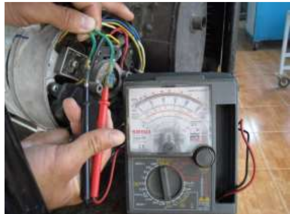
Hình 5.42.c. Đo thông mạch cuộn dây 12V
