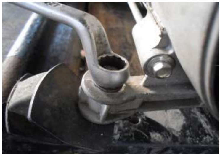
Hình 5.34. Lắp ốc cố định máy phát với giá đỡ
