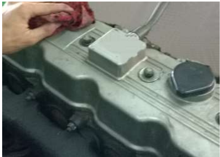
Hình 4.17. Vệ sinh tổ máy phát điện
