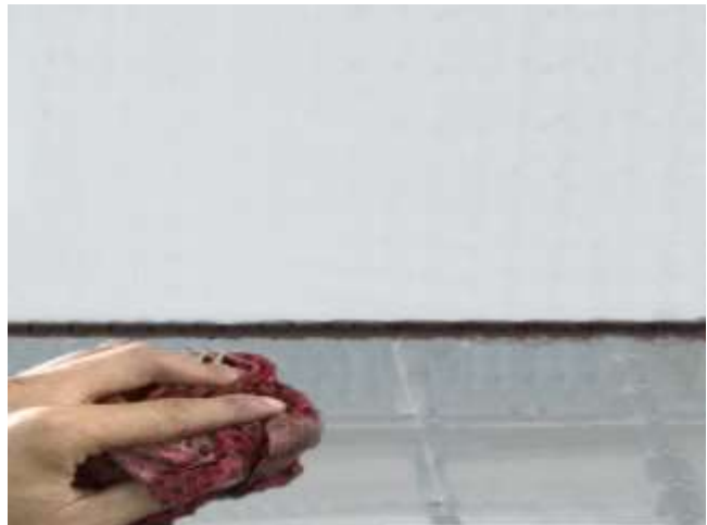
Hình 2.7. Vệ sinh vị trí lắp đặt
