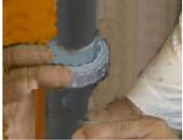
Hình 7.19. Lắp đai ốc liên kết từ ống dẫn gas đến bộ lọc khí
