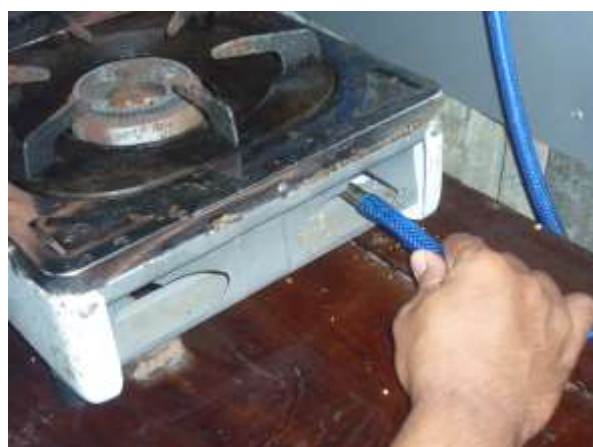
Hình 2.2.11. Lắp ống dẫn khí
