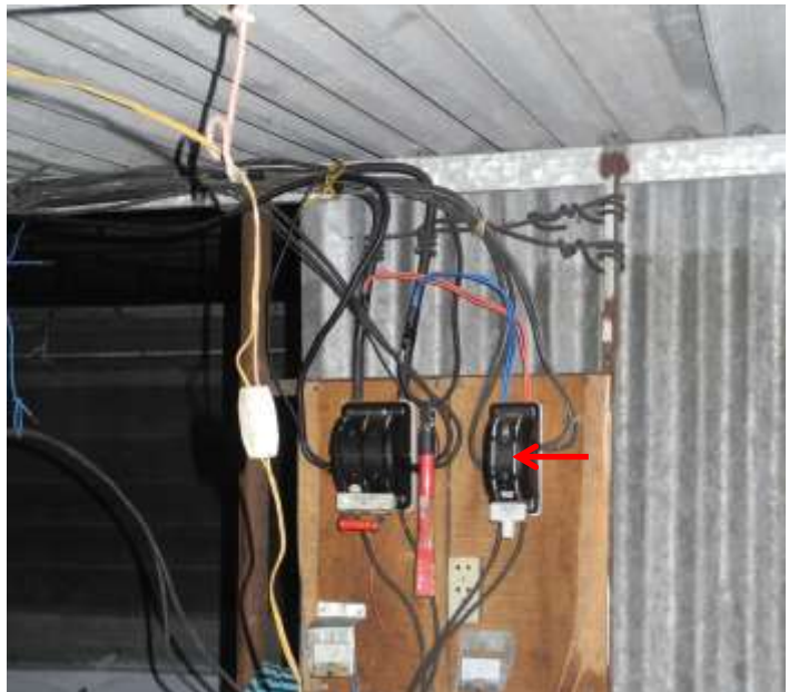
Hình 4.5. Cầu dao đảo phải đóng sang vị trí giữa (vị trí mũi tên chỉ) khi chuẩn bị khởi động
