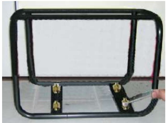
Hình 2.10. Lắp đặt giá đỡ vào đúng vị trí
