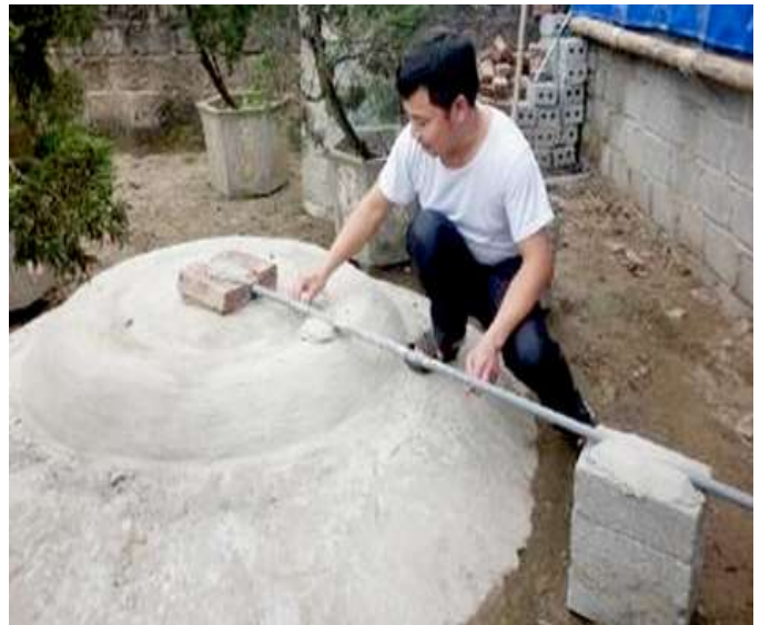
Hình 1.2.30. Hầm KSH xây gạch trát xi măng
