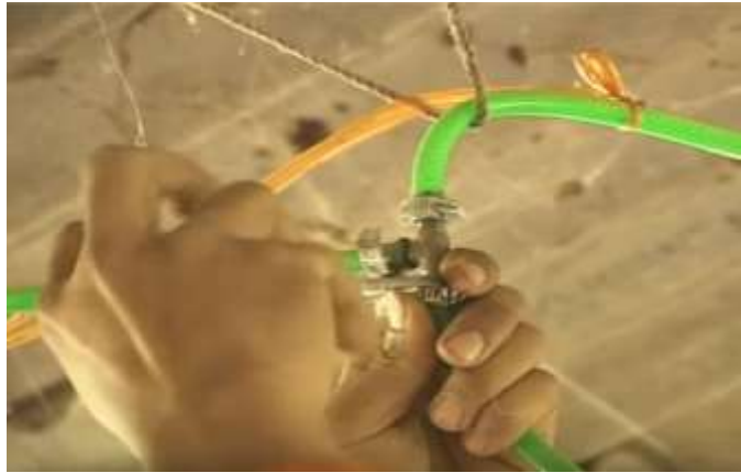
Hình 3.9. Lắp đặt đường ống dẫn khí
