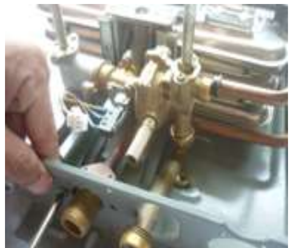
Hình 2.5.16. Lắp vít cố định đầu nối ống dẫn nước (lạnh)
