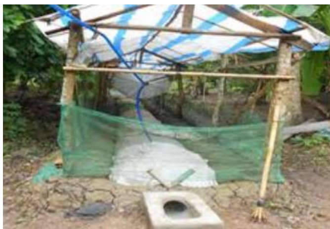
Hình 1.3.10. Mái che và rào xung quanh hầm ủ KSH
