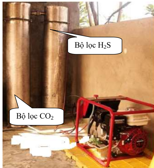
Hình 3.10. Lắp bộ lọc khí biogas
