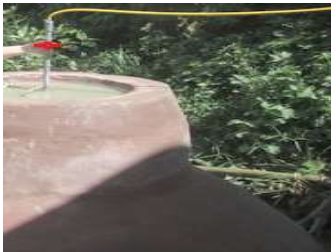
Hình 7.10. Đóng khóa cung cấp khí biogas
