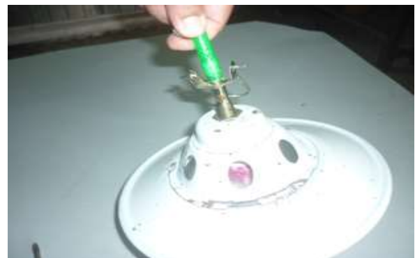
Hình 2.3.16. Nối ống dẫn KSH vào đèn
