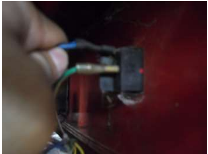
Hình 5.39. Lắp dây công tắc máy
