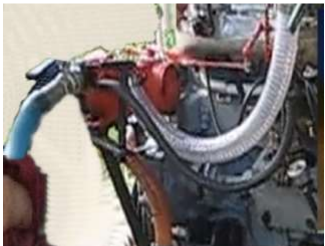
Hình 3.8. Làm sạch ống dẫn khí biogas
