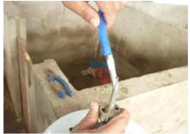
Hình 2.3.34. Lắp đặt đèn vào ống dẫn khí
