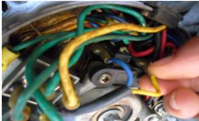
Hình 5.48. Tháo dây nguồn kích từ nối vào chổi than
