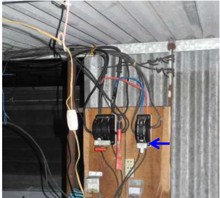
Hình 4.15. Đóng cầu dao đảo sang vị trí cấp nguồn
