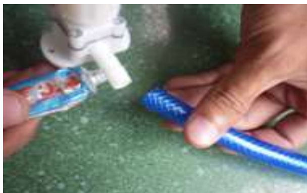
Hình 2.4.13. Lắp van khóa khí
