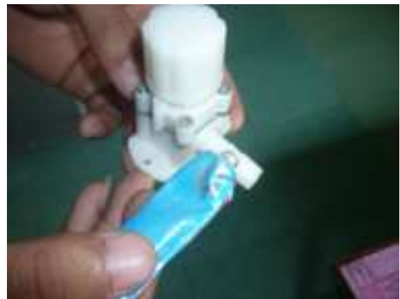
Hình 2.5.38. Lắp van khóa KSH
