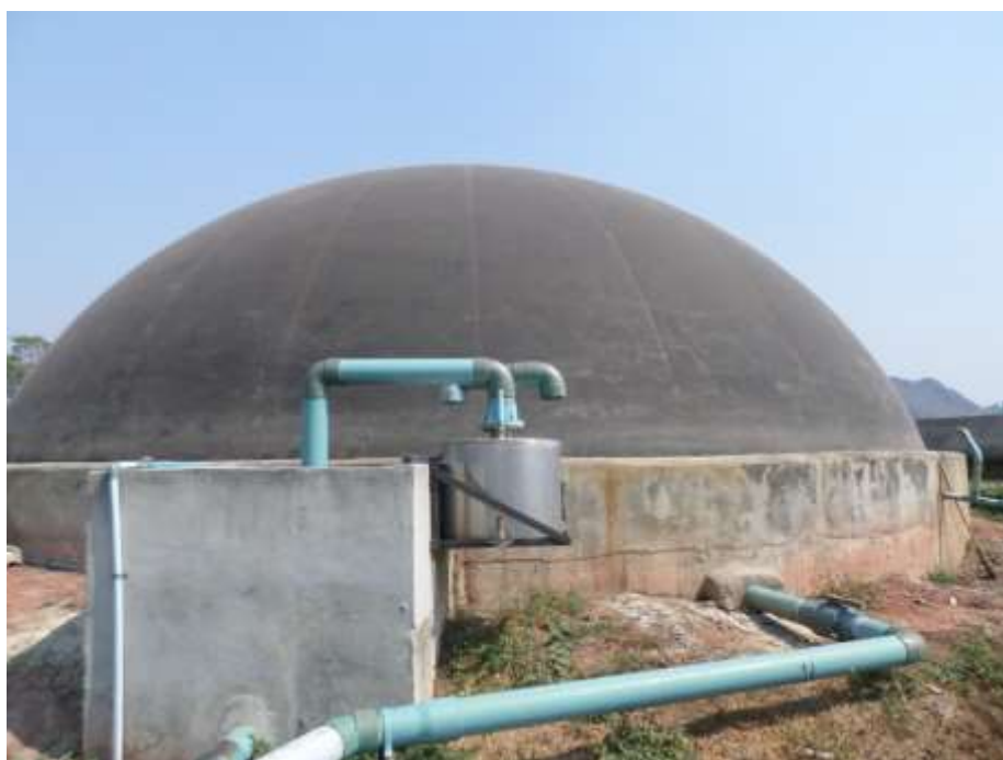
Hình 1.2.33. Hàm ủ KSH được làm quỳ mô, kiên cố
