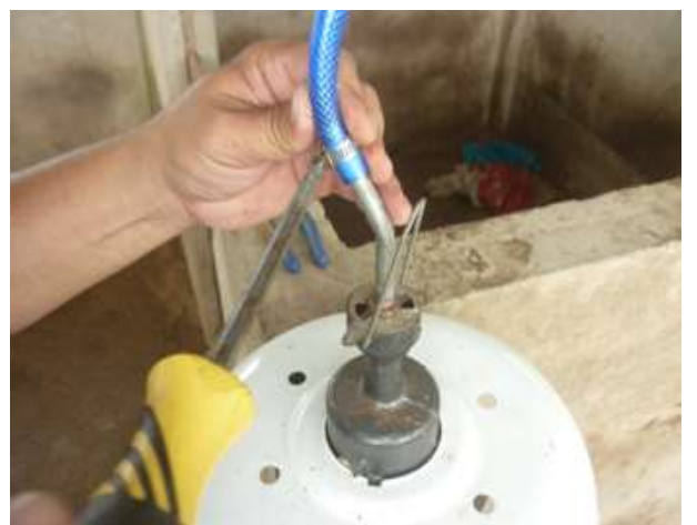
Hình 2.3.35. Siết chặt ống dẫn khí bằng đai siết
