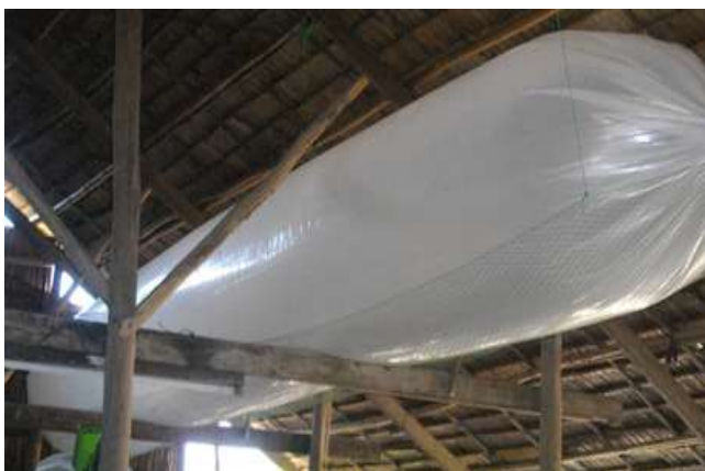
Hình 1.4.6. Túi chứa KSH để dự trữ hay để sử dụng
