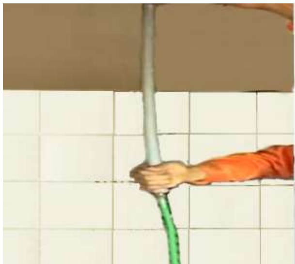
Hình 2.5. Lắp ống dẫn gas từ hầm biogas
