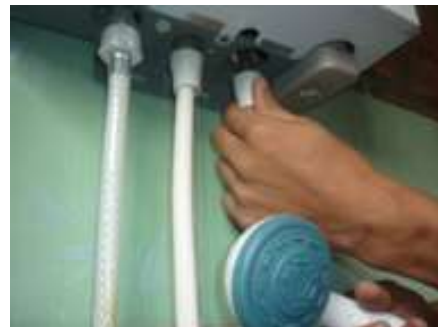
Hình 2.5.47. Chuẩn bị lắp nối ống dẫn nước (nóng) ra từ thiết bị
