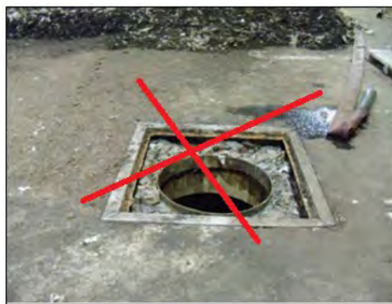
Hình 1.2.12. Hố ga không đầy nắp
