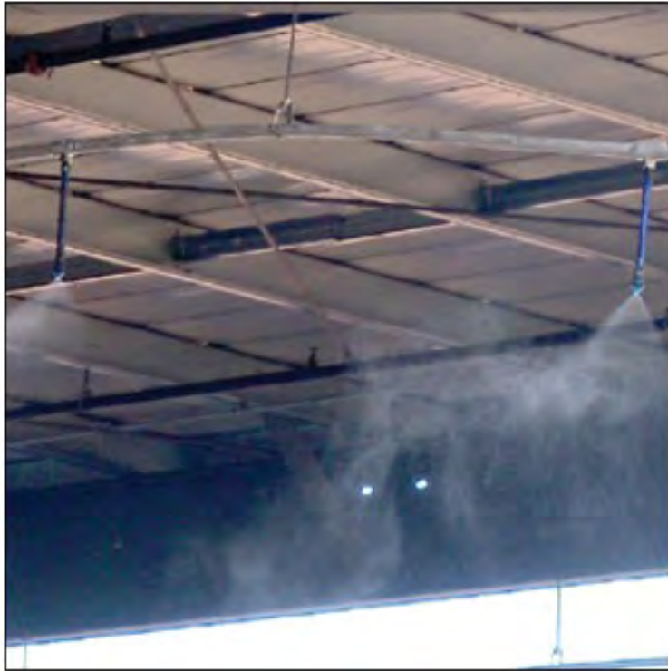
Hình 1.3.11. Hệ thống phun sương giảm bụi trong xưởng sản xuất phân HCSH
