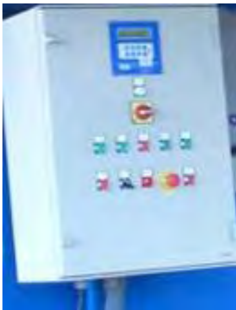
Hình 3.4.18. Bảng điều khiển thiết bị trộn
