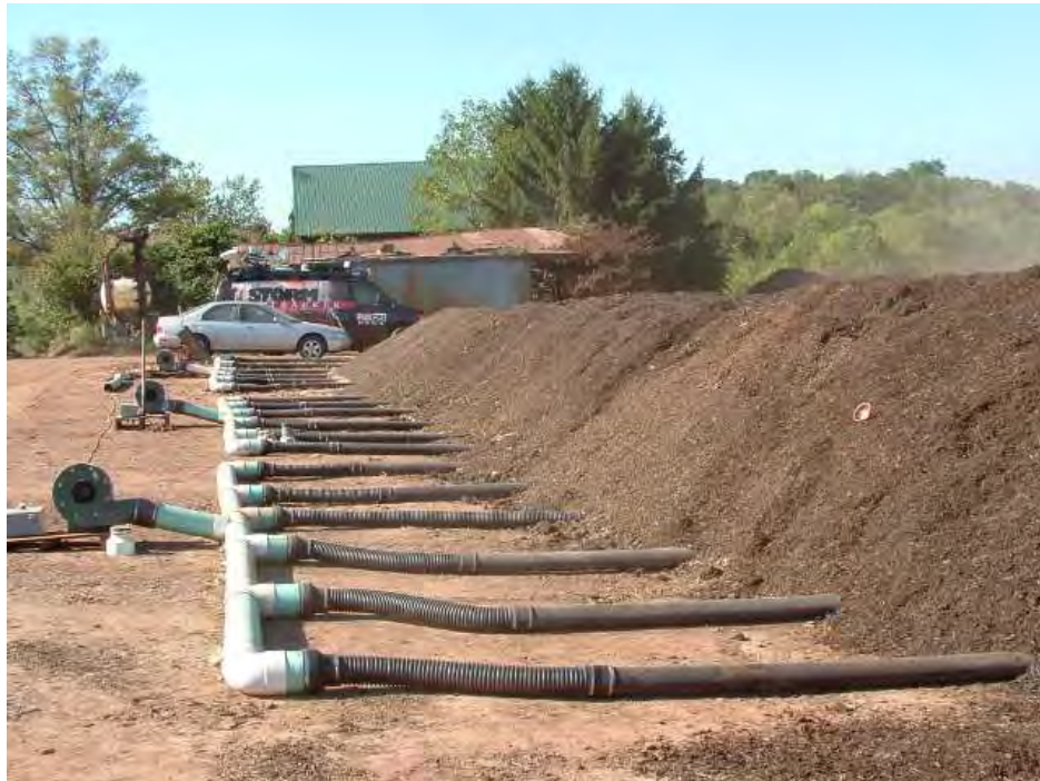
Hình 1.1.14. Dạng luống kiểu tĩnh cấp khí cưỡng bức
