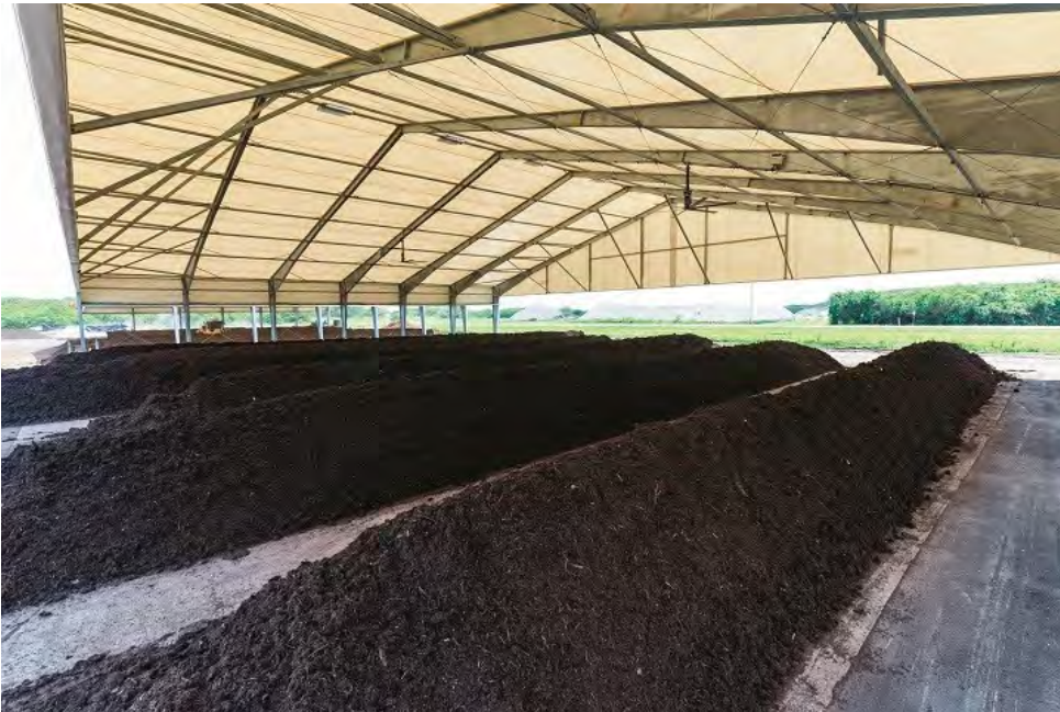
Hình 1.2.5. Nhà xưởng được thiết kế hợp lý cho thông gió tự nhiên
