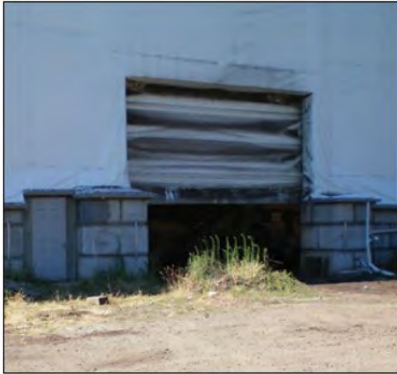
Hình 1.2.6. Cửa mở ảnh hưởng xấu đến hệ thống thông gió
