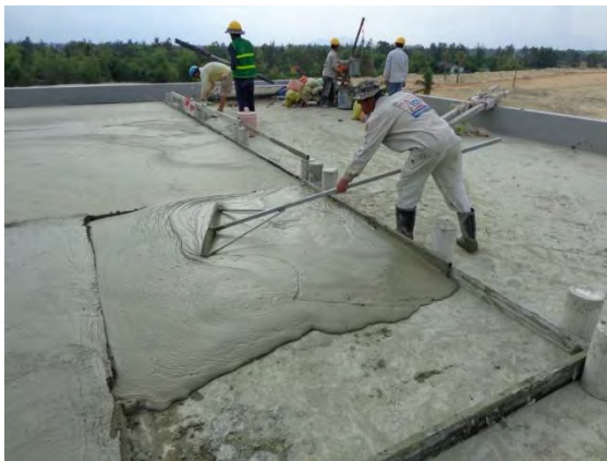
Hình 3.6.3. Làm sân phơi bằng bê tông xi măng
