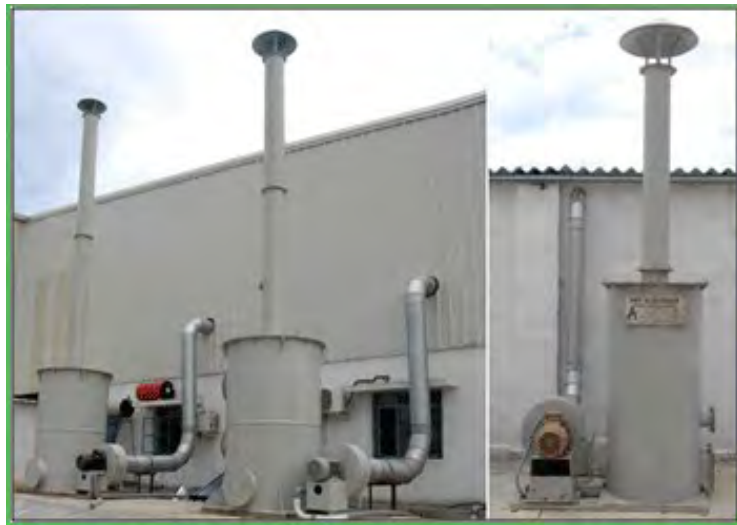
Hình 1.3.12. Hệ thống hấp phụ bằng các bon
