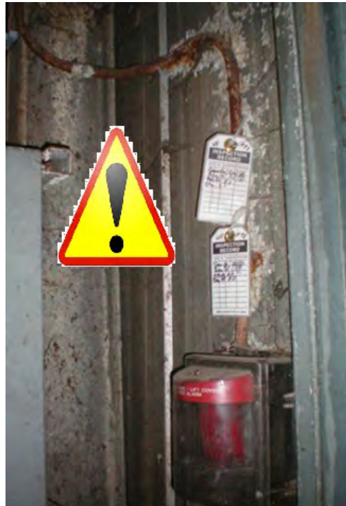
Hình 1.2.15. Hệ thống báo cháy có thể bị hỏng do ăn mòn
