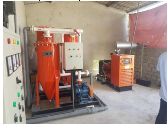
Hình 1. Mô hình máy phát điện KSH chuyên dụng nhập khẩu với công suất 5 kVA tại Lào Cai và 60 kVA tại Bình Định của dự án LCASP
