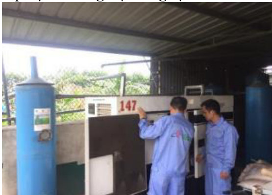
Hình 2. Thử nghiệm máy phát điện KSH cải tạo từ máy phát điện chạy bằng diesel công suất 45 kVA của dự án LCASP tại Nam Định và 100 kVA tại Phú Thọ
