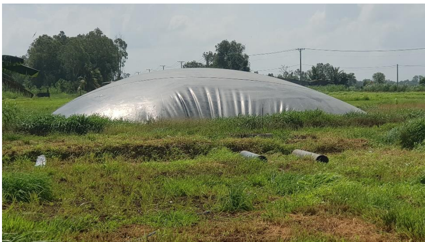
Hình 1: Hầm bioga dung tích lớn với ống xả khí ga
