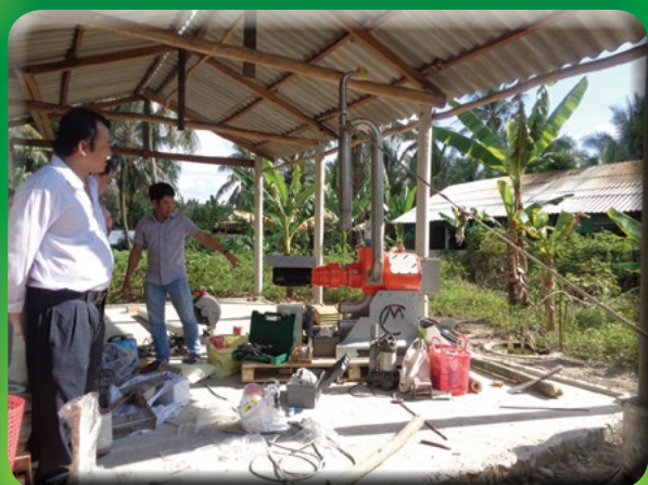
Lắp đặt hệ thống máy tách phân (mô hình HP3) ở Bến Tre
