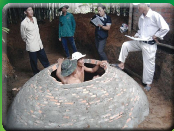
Xây dựng công trình KSH quy mô nhỏ ở Tiền Giang
