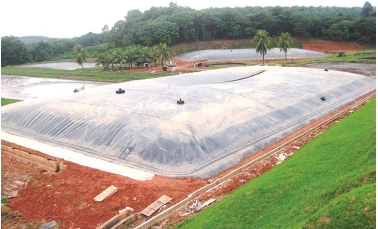
Nếu không sử dụng hết khí gas, hầm biogas HDPE cỡ lớn có thể trở thành tác nhân gây ô nhiễm
