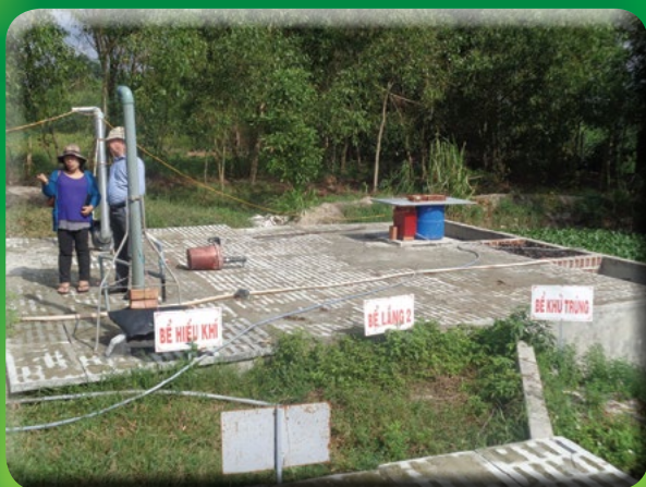
Hệ thống bể lắng lọc nước thải sau biogas của trang trại quy mô lớn
