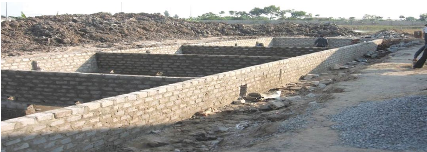
Công trình KSH xây dựng bằng gạch xi tại Công ty Tổng hợp Hà Nam
