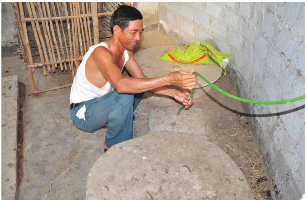
Ông Hồ Việt Hải (Hà Tĩnh) sửa chữa hư hỏng hầm biogas
