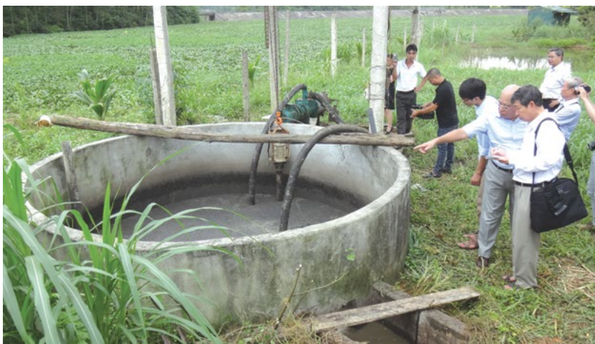
Sau khi tách phân, nước thải được xử lý trong bể lắng
