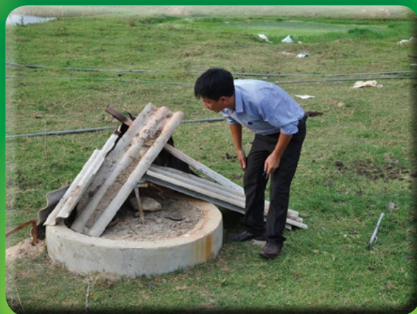
Kiểm tra, xử lý sự cố hầm biogas
