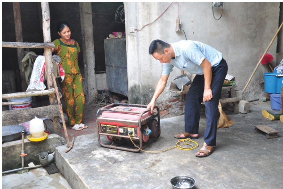
Máy phát điện từ KSH khắc phục tình trạng thừa khí biogas và thiếu điện
