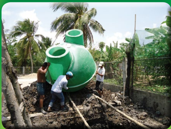
Lắp đặt hầm KSH composite tại Sóc Trăng
