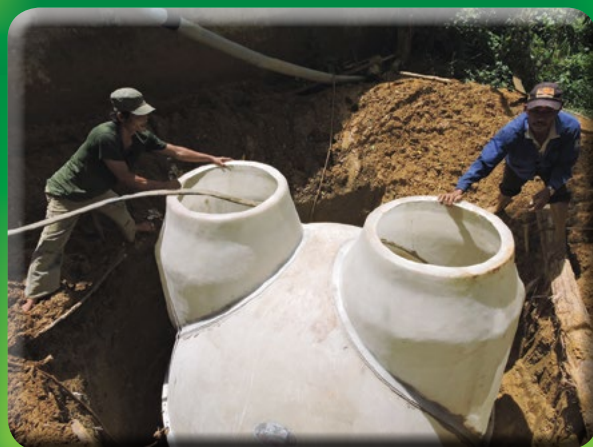
Lắp đặt hầm KSH composite tại Bình Định
