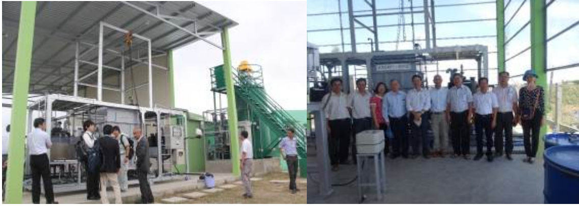
Hình 1. Ảnh chụp PTN Trình diễn Dự án (Demo-site) tại Công ty Hoàng Vũ, Bình Đại, Bến Tre
