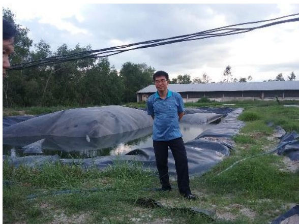
Hình 3: Hầm bioga lớn bị rách không được sửa chữa
