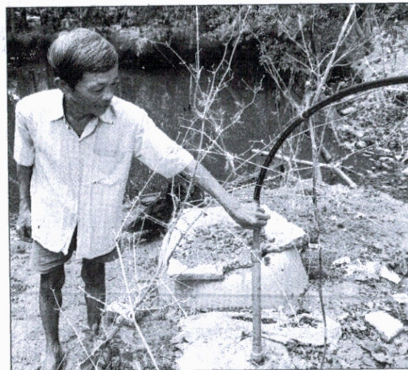
Ông Nguyễn Văn Giữa (xã An Hiệp, huyện Ba Tri) kiểm tra van dẫn khí gas từ hầm vào nhà (ảnh: MB)
