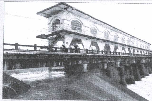
Hệ thống thủy lợi An Trạch
