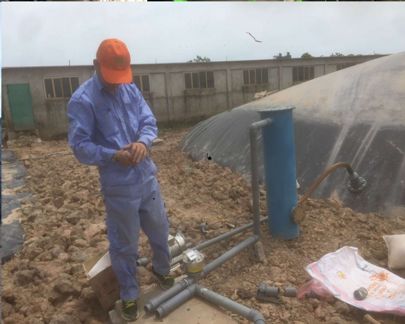
❑ Lắp đặt hệ thống chia sẻ khí gas
