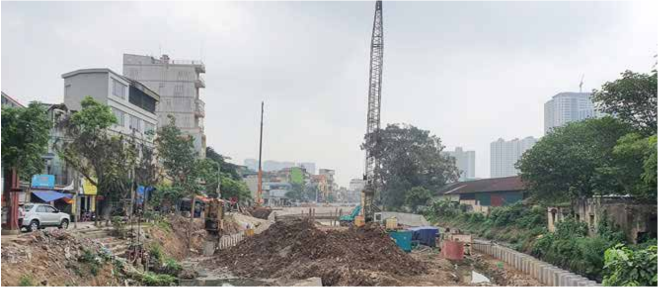
▲ Công trình kè kênh La Khê, quận Hà Đông, Hà Nội
