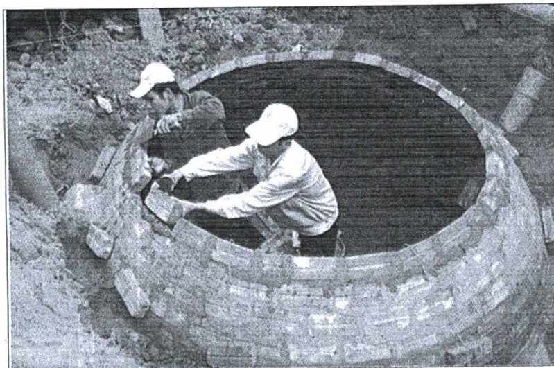
Công trình xây hầm biogas ở Bến Tre
