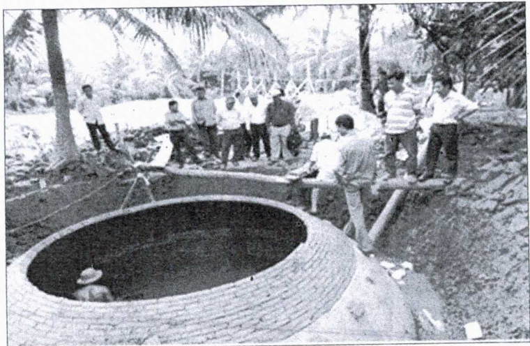
Công trình xây hầm biogas phù hợp hộ chăn nuôi quy mô vừa và nhỏ
